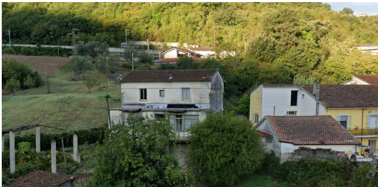
- FOTO 1 “attuale” (ripresa N-E )
