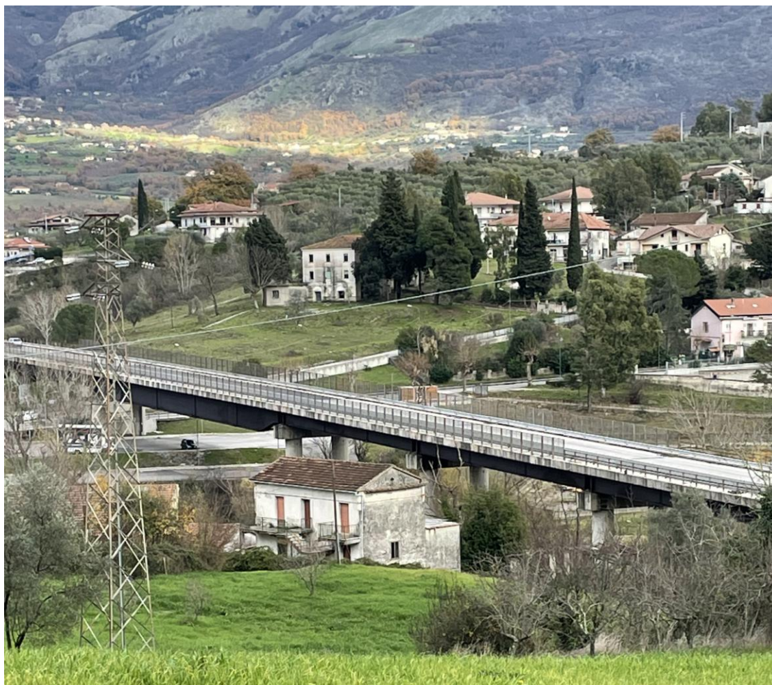
- FOTO 2 “attuale” (ripresa S-E)
