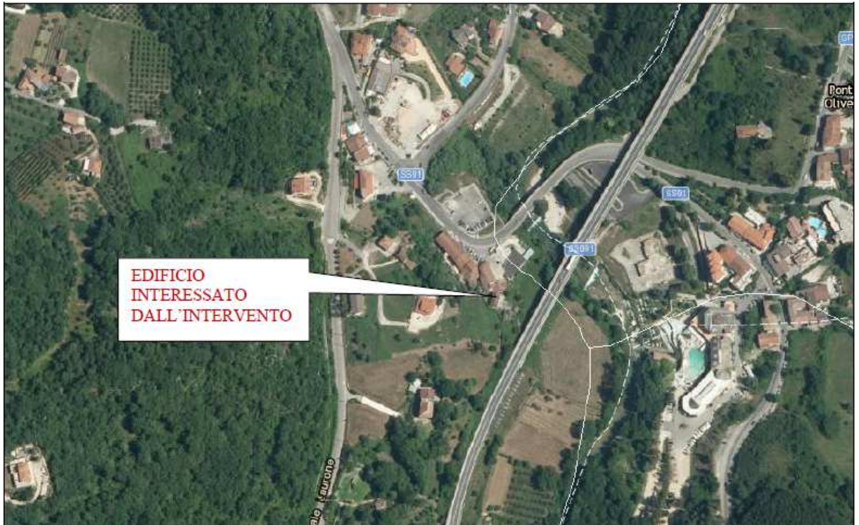
Vista aerea dell'area di intervento
